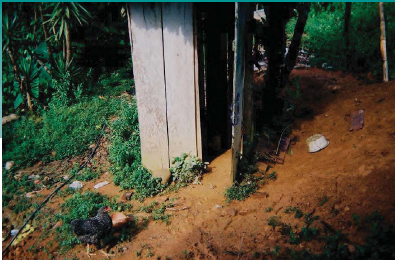
Letrina rural, Honduras. Fotografía: Michael Campana.
