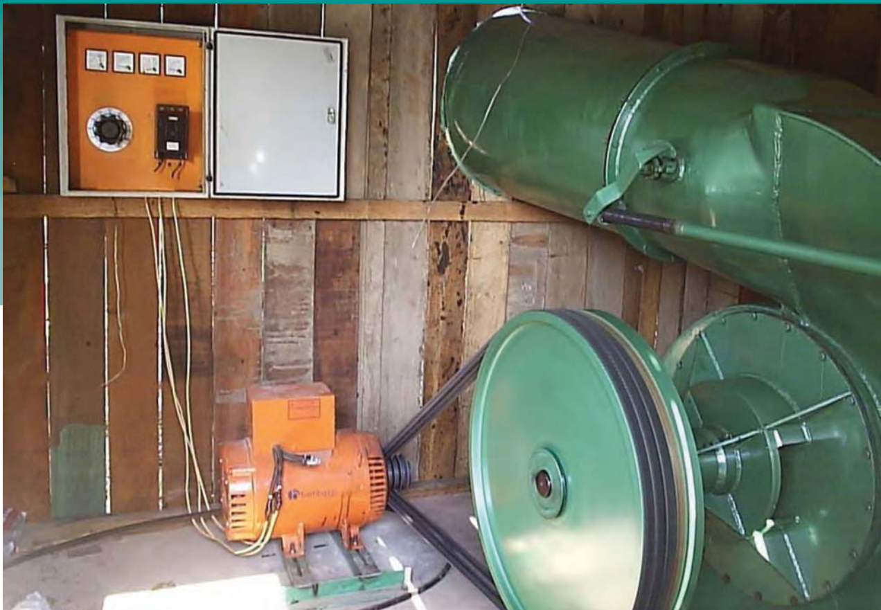
Pequeña turbina y generador de energía hidráulica, que forman parte de un proyecto piloto para instalar una “mini red” de suministro de energía renovable para el lejano pueblo de Cachoeira de Aruã en Brasil, a 145 km de Santerem, sobre un afluente del Amazonas. Fotografía: Indalma Industria/Nazareno Natalino/USAID.
