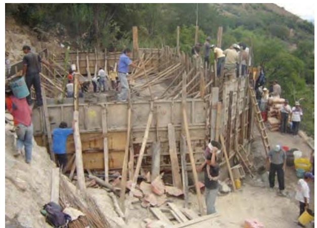
Campeños, vecinos y funcionarios locales construyen un embalse para la provisión de agua a las granjas de Santa Rosa de Ocana, en Ayacucho, Perú. Fotografía: USAID.
