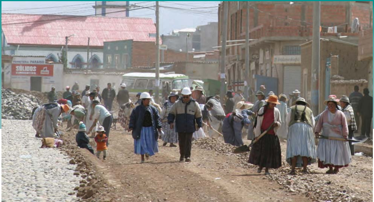
Proyecto de infraestructura pública (construcción vial) en El Alto, al norte de La Paz, Bolivia. Fotografía: USAID.
